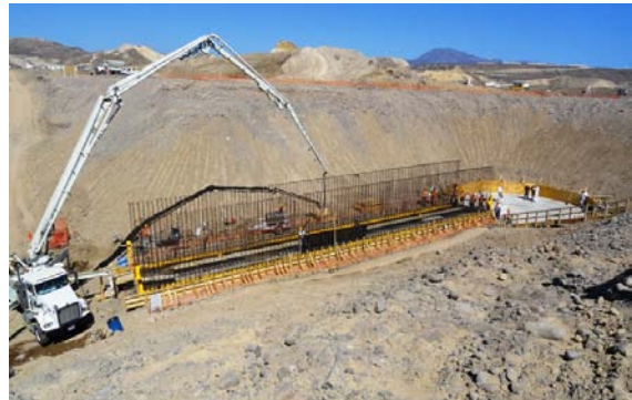
FIRST CONCRETE POUR (CCD THICKENERS)– MAR 2011
